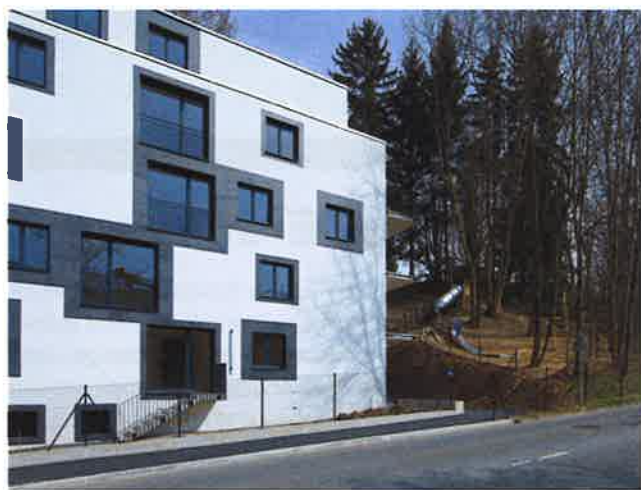
Tribu architectes machen in Lausanne mit verspielter Schwarz-Weiss-Grafik aus einer Aussendämmung eine charakterstarke Gebäudehülle.
